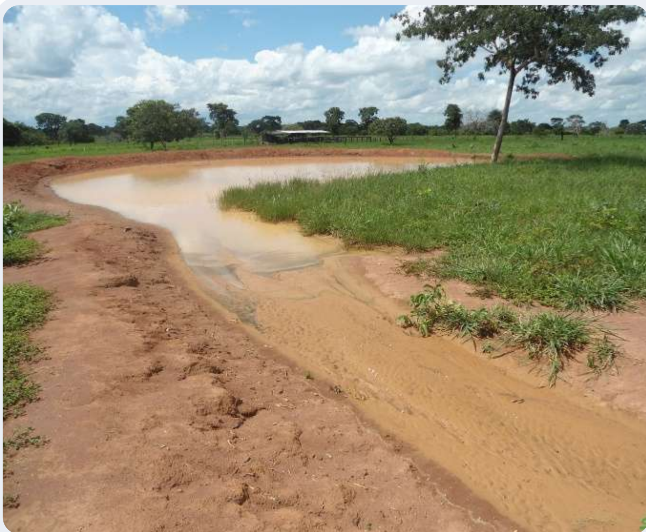
Figura 10 - Barraginhas construídas no PA Rancho da Saudade, no município de Cáceres, MT.
